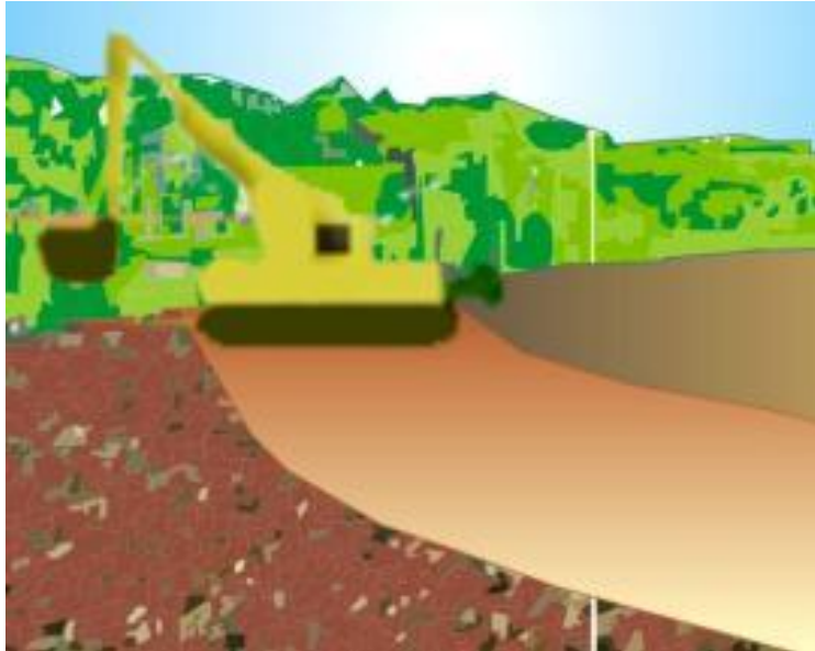
Gambar 55. Pembuatan Tanggul Di Penampungan Lumpur
