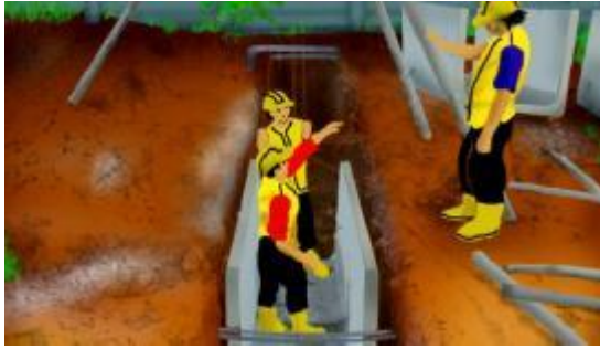
Gambar 81. Pengangkatan Lining Saluran Yang Ambblas
