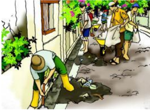
Gambar 58. Pengangkatan Sedimen Di Saluran
