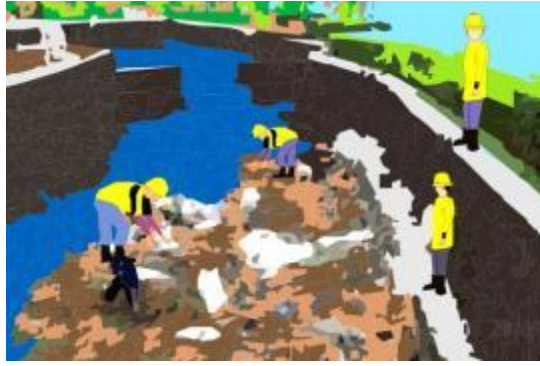
Gambar 87. Memasukkan Sedimen Ke Dalam Karung Di Bangunan Terjun
