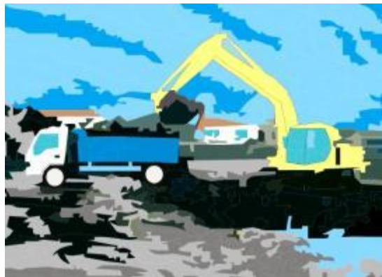
Gambar 99. Pemindahan sedimen dari bak penampung ke dump truck
