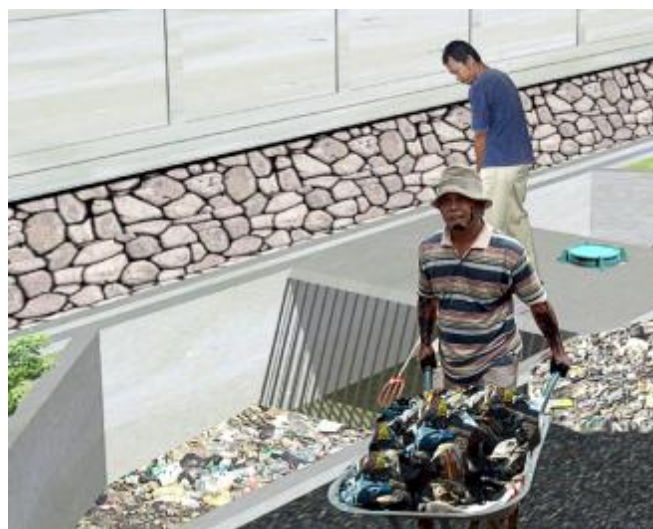
Gambar 52. Pengangkutan Sampah Di Trash Rack Manual
