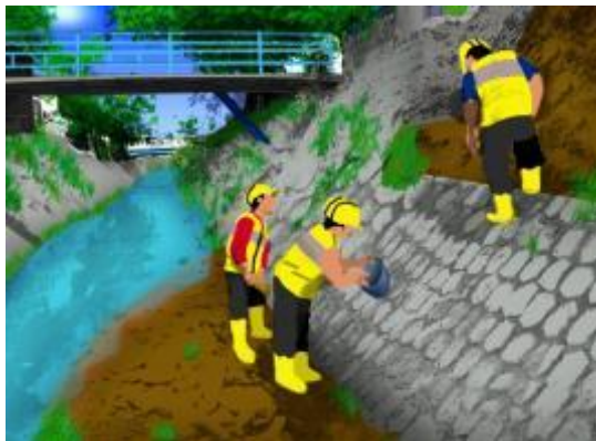
Gambar 78. Pemasangan Talud Batu Kali
