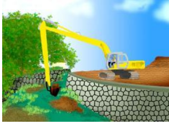
Gambar 69. Excavator mengeruk sedimen di pinggir sungai
