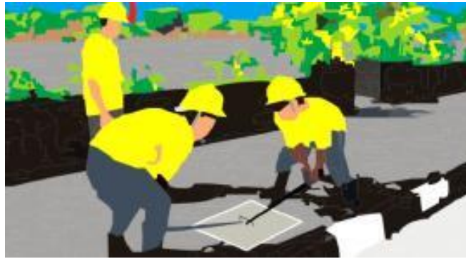
Gambar 64. Pengangkatan Tutup Man Hole
