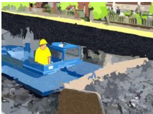
Gambar 73. Pengerukan Sedimen Dengan Bulldozer Keruk
