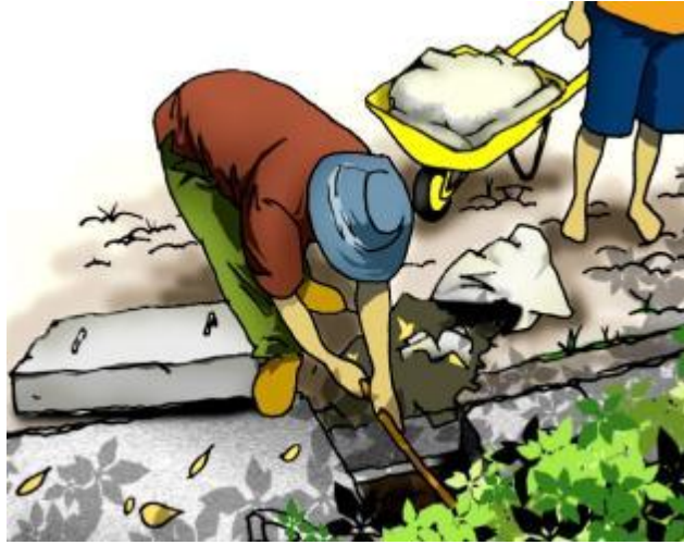
Gambar 62. Pembersihan Sedimen Di Saluran Tertutup
