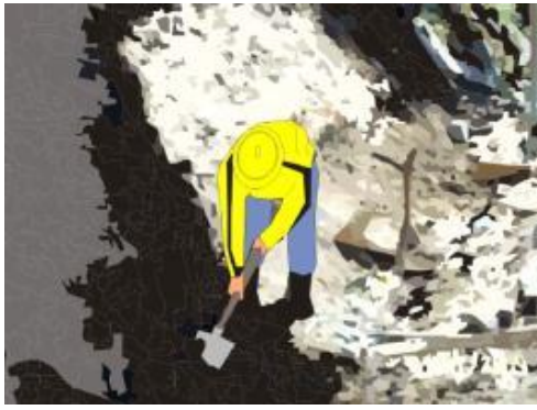
Gambar 77. Penggalan Tanah Pondasi
