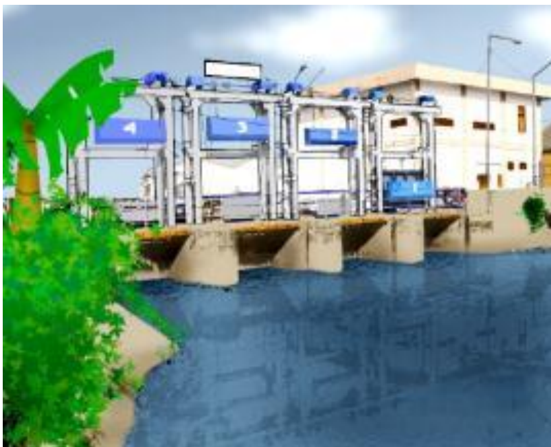
Gambar 42. Pintu dan Pompa Air dengan rumah genset
