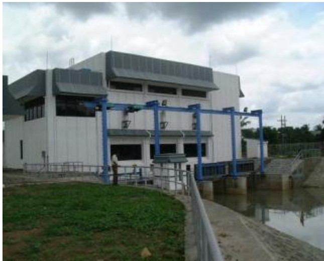
Gambar 23. Pompa dan Rumah Pompa
