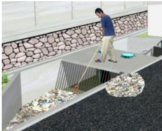
Gambar 51. Pembersihan Trash Rack Manual
