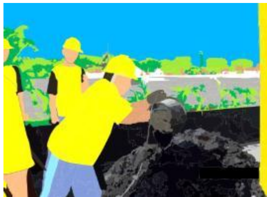
Gambar 67. Menumpuk Sedimen Untuk Ditiriskan
