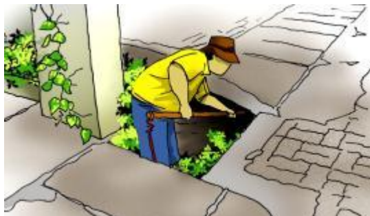
Gambar 82. Penggalan Sedimen Di Gorong-Gorong Berukuran Kecil
