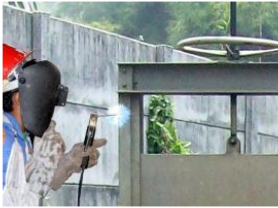
Gambar 95. Pengelasan pintu air yang rusak
