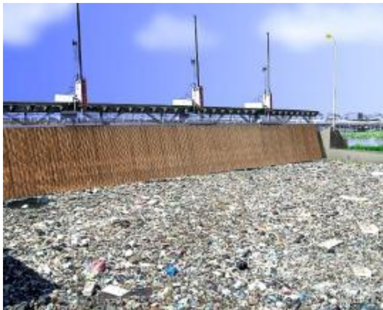
Gambar 46. Tumpukan Sampah di Depan Trash Rack
