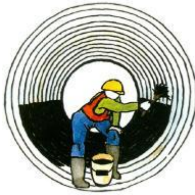
Gambar 84. pengecatan gorong-gorong plat baja
