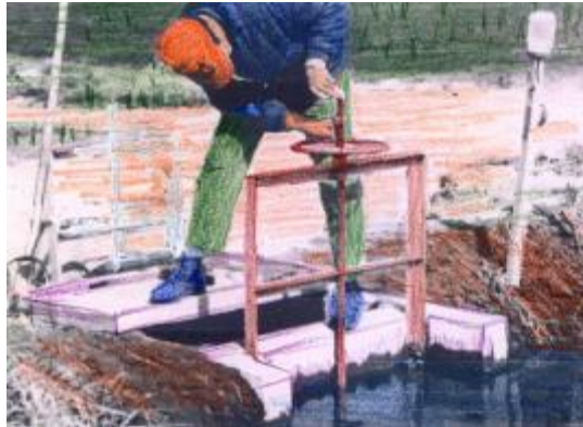
Gambar 93. Pengecatan Pintu Sorong
