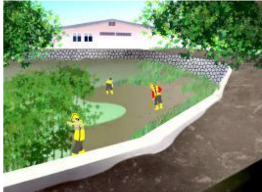
Gambar 103. Pembersihan Kolam Retensi Secara Manual
